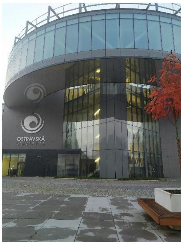
Nowy budynek Wydziału Pedagogicznego Uniwersytetu w Ostrawie – siedziba Human Movement Diagnostics Center.
